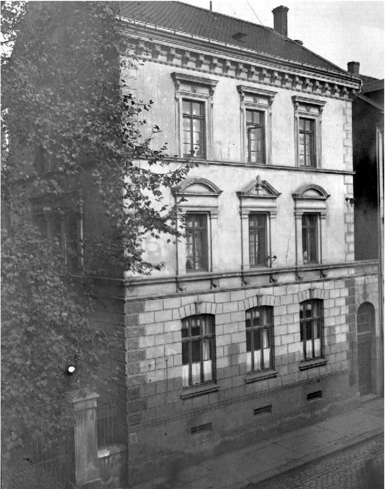
Seitlich rechts, aber vorn an der Straße, schloss sich an das Stahlgittertor in gleicher Fluchtlinie ein 3-geschossiges Gebäude mit einer Gründerzeitfassade an: die israelitische Schule. Sie hatte die Hausnummer Wilhelmstraße 16, während die schräg dahinter liegende Synagoge Wilhelmstraße 18 war.
