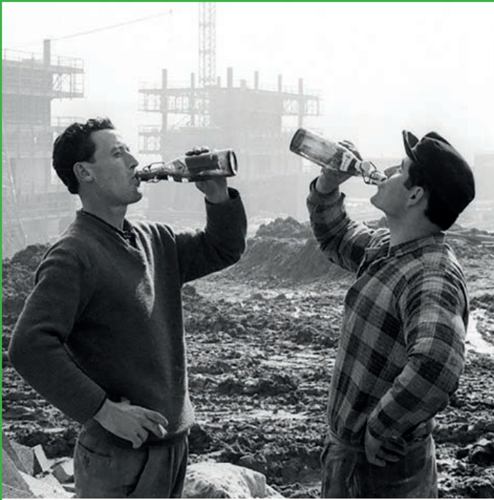
Bau der Ruhruniversität 1965
