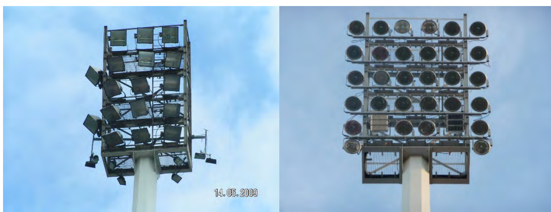
Abbildung 12: alte Flutlichtanlage / neue Flutlichtanlage
